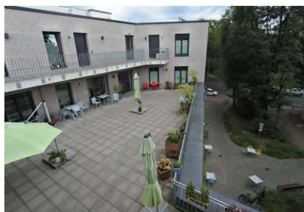
写真 24 上下の関係がつくられるテラス
