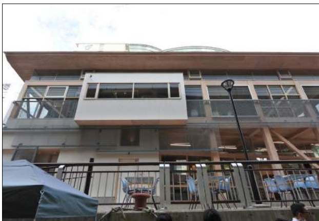
写真5 河川側のファサードデザイン
