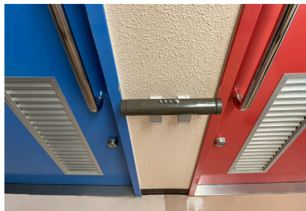
写真4 廊下の手すりのビス
