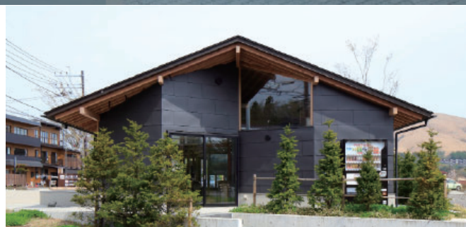
写真3 西側のファサードを見る
