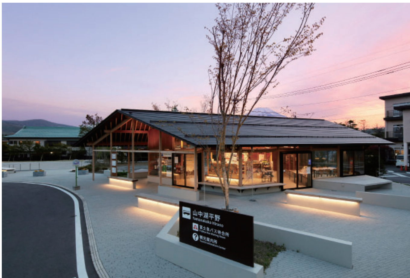
写真2 バスロータリー工区全景
