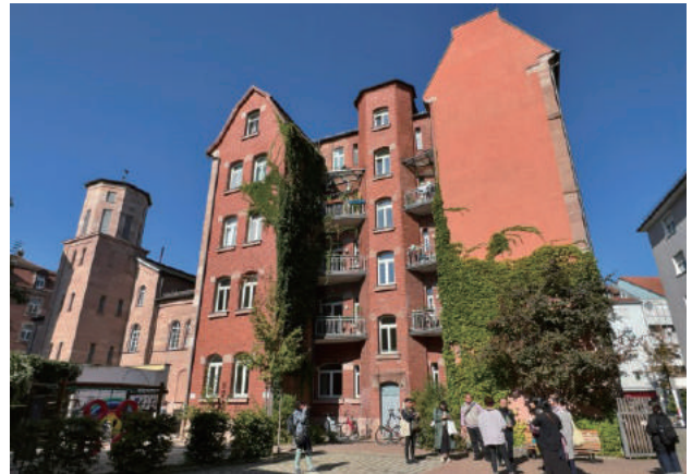
写真6 建物b (多世代の家, 里親仲介, 市営住宅棟)
