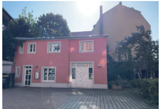
写真7 建物c (発達支援センター棟)
