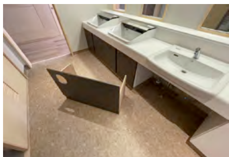
写真 21. 配管の目隠しボード
