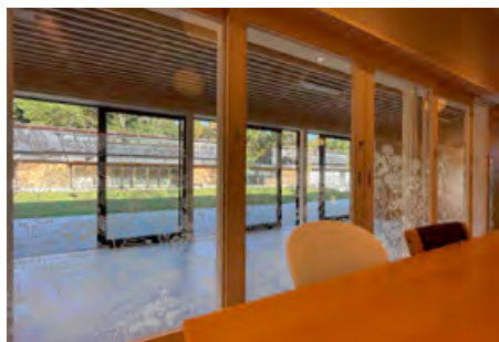
写真12. ユニットと縁側廊下間のガラス戸
