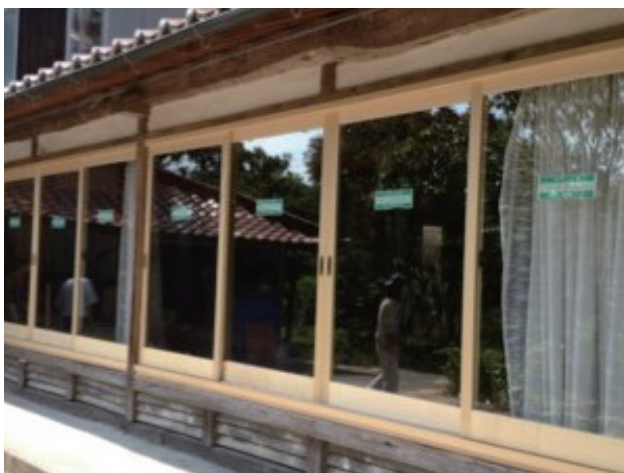
写真9 えんがわ部分の改修後① (ピンクの囲い部分右側)
