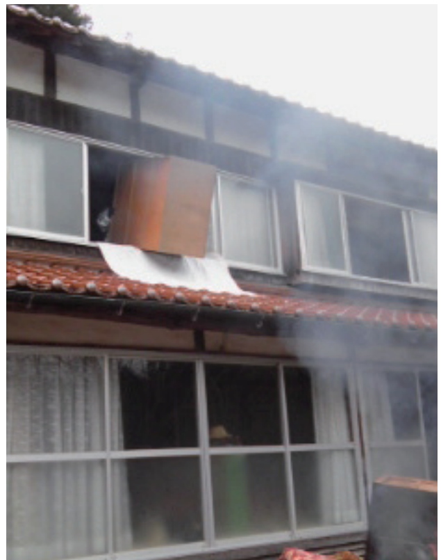
写真8 えんがわ部分の改修前（ピンクの囲い部分右側）
