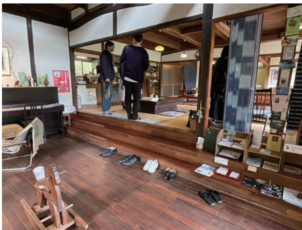
写真7 土間部分の改修後（ピンクの囲い部分左側）
