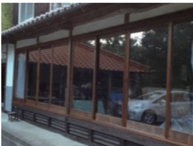
写真10 えんがわ部分の改修後② (ピンクの囲い部分右側)
