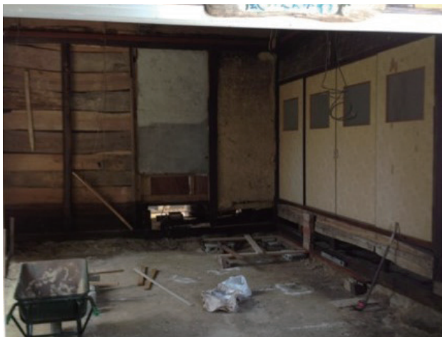
写真6 土間部分の改修前（ピンクの囲い部分左側）
