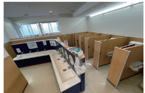
写真14 第一幼稚園 トイレ
