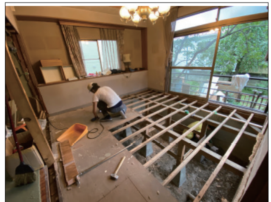
写真2. 改修の様子（サイトより）
