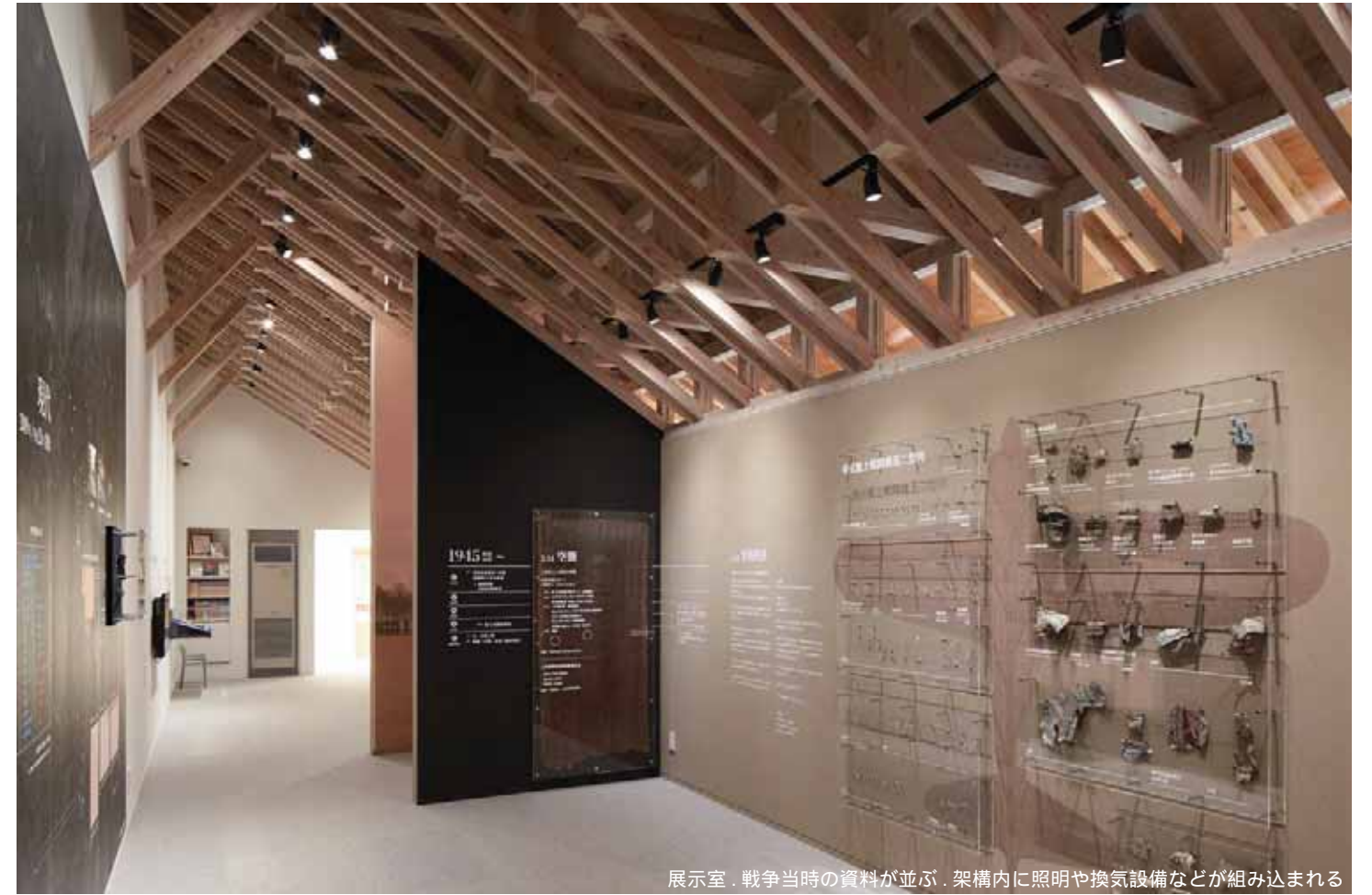
多目的スペース。主要部は天井アラワシとし、架構をそのまま見せている
