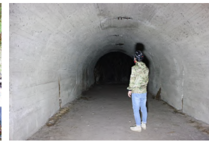
地下魚雷調整場跡内部
