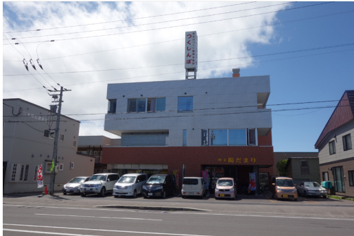
写真1. 外観：幹線道路に面する。奥がGHの入り口
