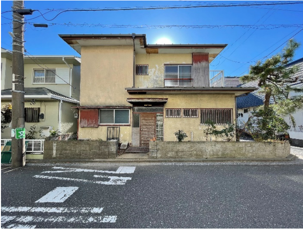
Fig. 2 対象とする空き家の外観
