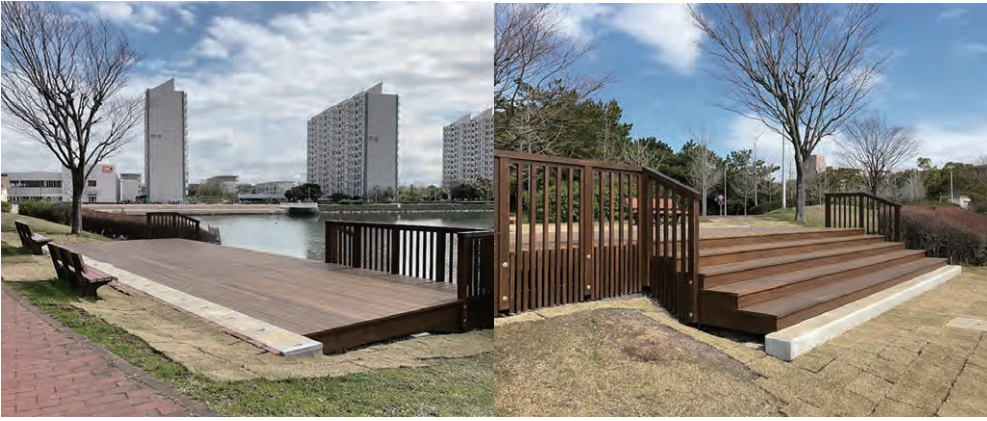
水辺に向かって設置されたウッドデッキ
