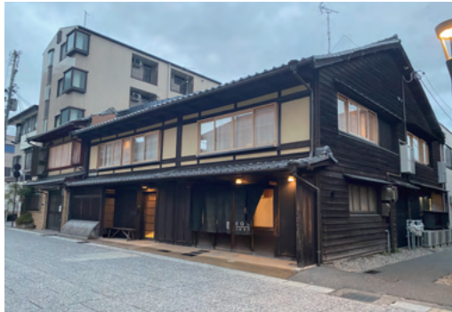
写真1. レセプション棟「近江屋」外観写真
