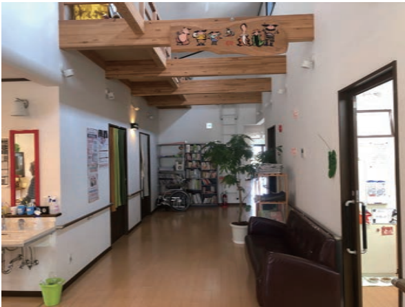
図 16. 有料老人ホーム「よるず家」、居室群側を見る 廊下の高い天井高を生かしてロフトスペースを設け、収納に活用している。こうした作り込みは断面方向の変化も生み、滞在空間にもなる廊下となっている。
