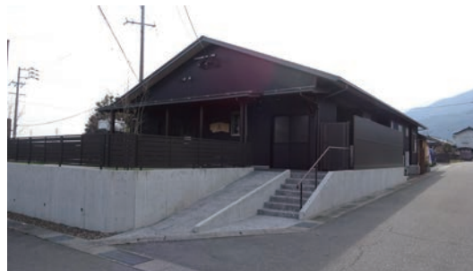
図7. 奥の出入口外のミニガーデン 直接道路からアプローチできる。
