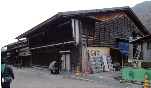
図1. 改修中の元・造り酒屋の主屋
