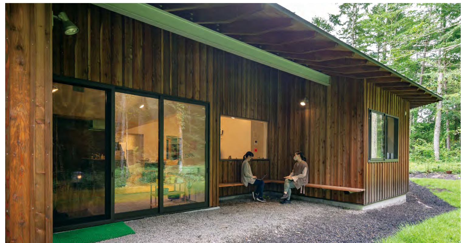
南側外観。いくつかの凹みに溜り場があり、建物内にアクセスできる。
