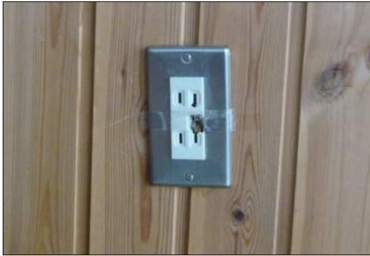
写真 10. 旧コンセント
