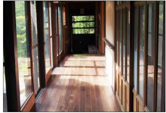
写真16. 備中長衛門 廊下（やかげ観光ネット HP より引用）
