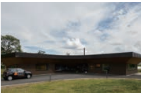
写真 48. マギーズフォースバレー(マギーズセンター HP から引用) 木材を使った往年のボード小屋風である。幾何学的に規則正しい継ぎ目のない木材を張った傘状の計上で屋根と壁を共用させる。
