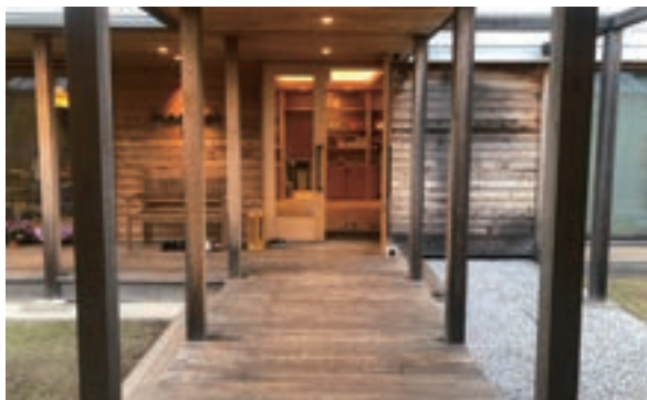
写真 10.2 棟をつなぐ渡り廊下
