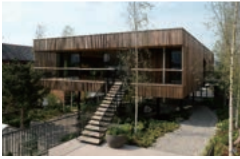
写真 27. マギーズオールダム (マギーズセンター HP から引用) 世界初のユリノキの堅材の工業材で覆った建造物
