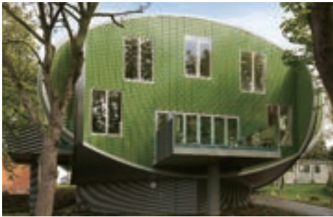
写真 39. マギーズノッティンガム(マギーズセンター HP から引用) 1 階は公的な空間で 2 階は、カウンセリングルームなどの個室で構成されている。
