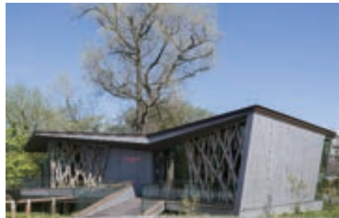
写真 44. マギーズオックスフォード (マギーズセンター HP から引用) 設計者のコンセプトの「アートと科学に橋をかける」である。人工地盤のように 3 つのウイングを作っている。
