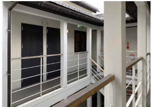
写真2 6. ワンルームタイプ棟の共用外廊下
