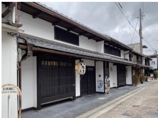
写真13. 一棟タイプ建物外観 幕末に建てられた築100年以上の建物
