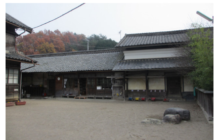
写真9 敷地内から見た塀蔵
