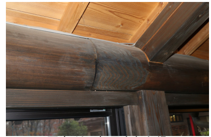
写真10 転用された梁
