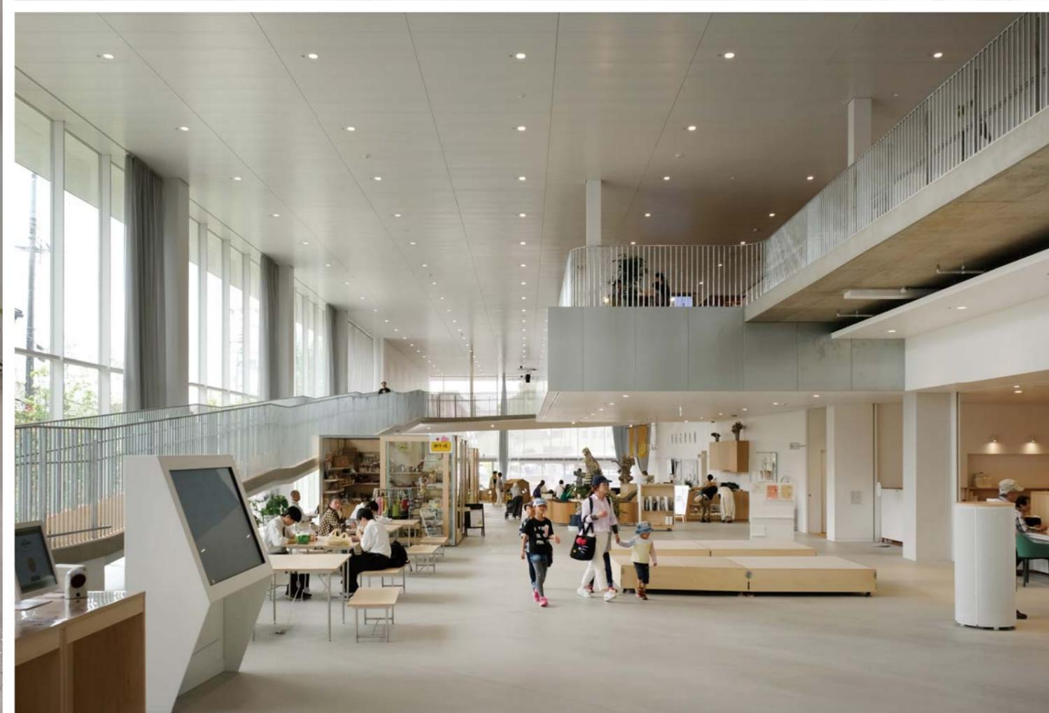
tette通り中央から西側を見る。跳ね出す2階スラブを3階メガストラクチャーから吊っている。
