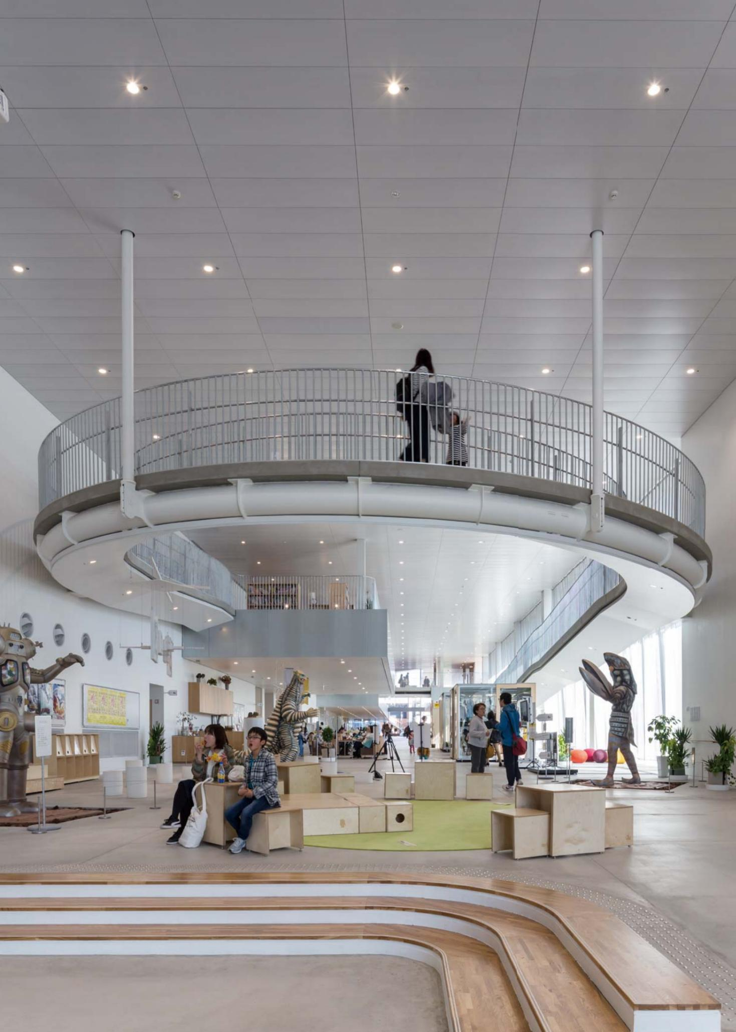
西側から見るtette通り。2階へ繋がるスロープは3階のメガストラクチャーから吊っている。
