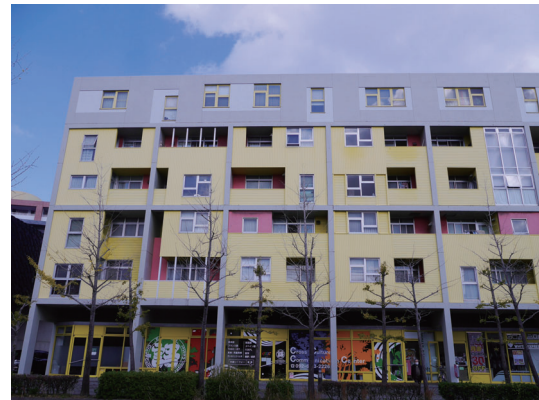
写真2. マーク・マック棟
