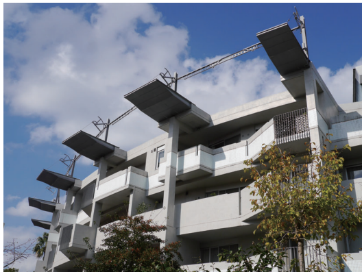
写真4. 石山修武棟 天井部分に突起が等間隔に並べられているインパクトのある建物。
