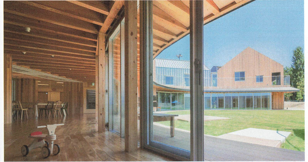
「ひろい道」から中庭を望む：低く放射状に連続する木架構が中庭まで連続し、軒下空間を作り出す
