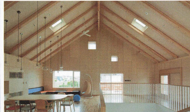
2階「みんなの部屋」：木の家型梁を象とし、家を感じられる安らげる場としている
