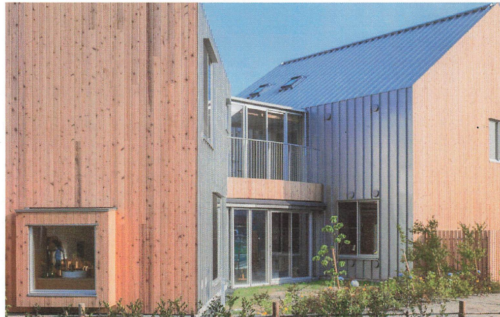
外壁はガルバリウム鋼板縦ハセ目と木製サイディング本実張り。家型と家型の間は「こどもの庭」「小さな庭」といった植栽で緩やかに区切られた屋外の落ち着いた居場所となる
