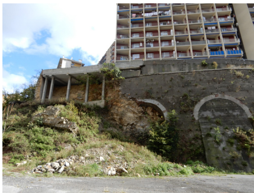
写真 15 敷地内から東側周辺をみる 敷地とのレベル差が大きく、擁壁が一部くずれている状態。
