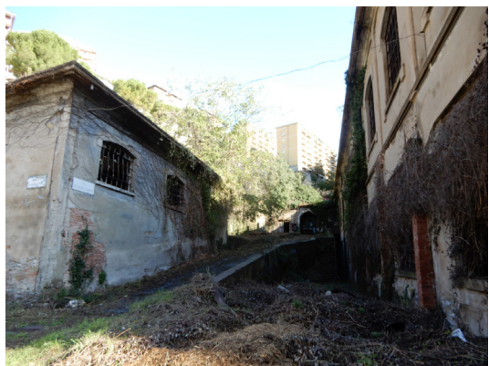
写真12 取り壊し予定の建物と敷地東側をみる
