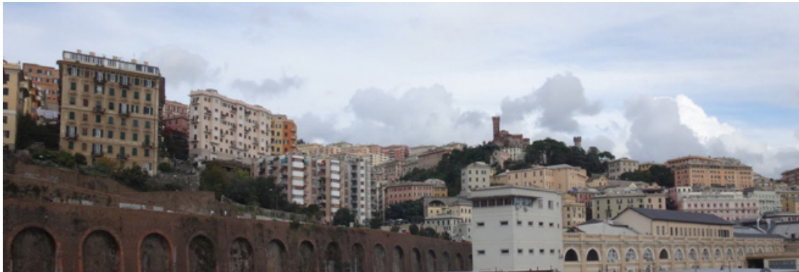
写真1 海岸側からみた、切り立つ斜面地に張り付く高層密集住宅群
