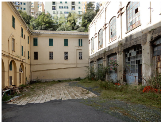
写真 13 保存建物（左）と解体建物（右） 左が中庭のある（地区の家が入っている）保存建物。右が解体予定の建物。正面に敷設された舗装は歴史的価値が認められるため保存指定。
