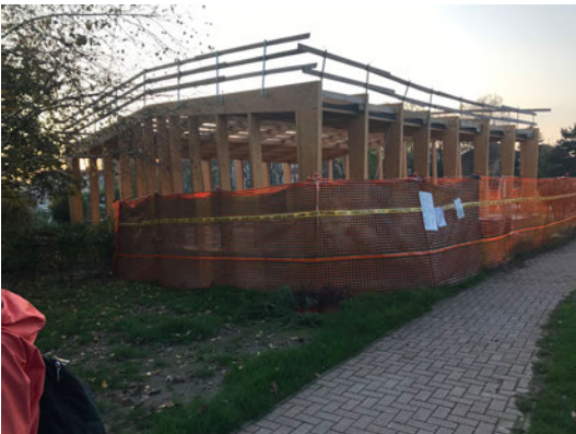
写真 23 建設中の温室
