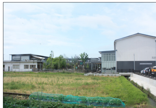
写真3. 施設を側道から見る。
