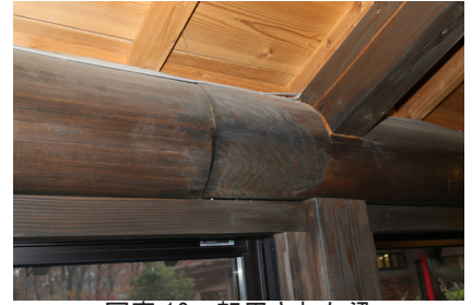
写真10 転用された梁
