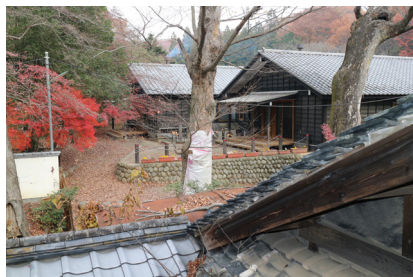
写真8 主屋裏の木造園舎群
