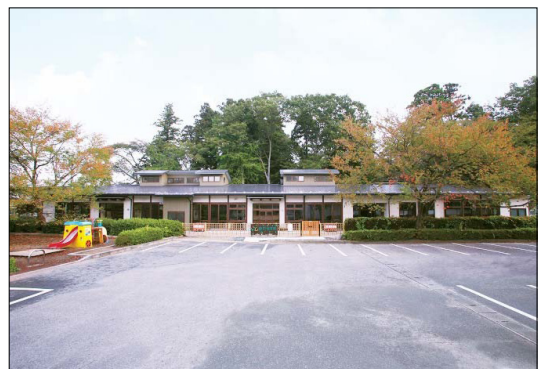
写真3. 外観写真（千葉建設株式会社 ホームページから引用）
