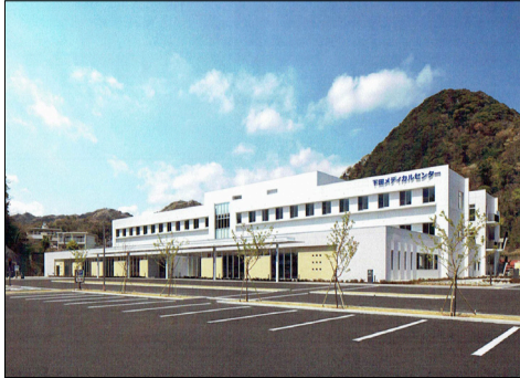
写真1. 外観写真（見学時資料より）
