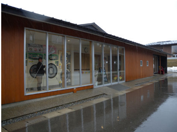
写真 2-41. クリーニング&ランドリー 事業所としてクリーニングを営んでいる。
