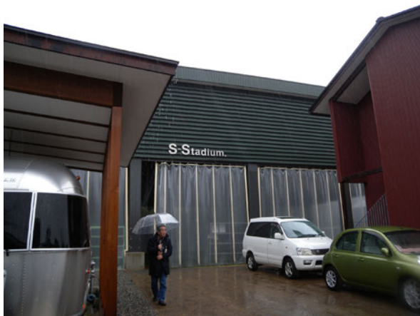
写真 2-37. スタジアム外観
